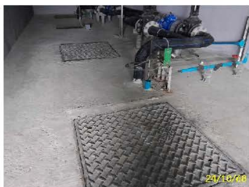
ฝาลังสำรองน้ำใช้ชั้นใต้ดิน อาคาร A และอาคาร B
