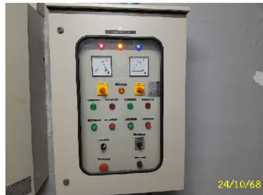
ปอร์รับน้ำฝนชั้นใต้ดิน และตู้ควบคุม ตัวที่ 3
