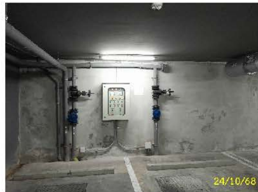
ปอร์รับน้ำฝนชั้นใต้ดิน และตู้ควบคุม ตัวที่ 2
