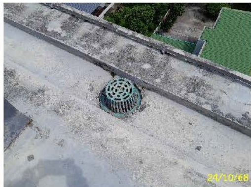
หัวรับน้ำฝนจากชั้นหลังคา
