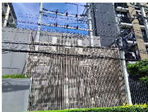
หม้อแปลงไฟฟ้า พร้อมแผงกันหม้อแปลง
