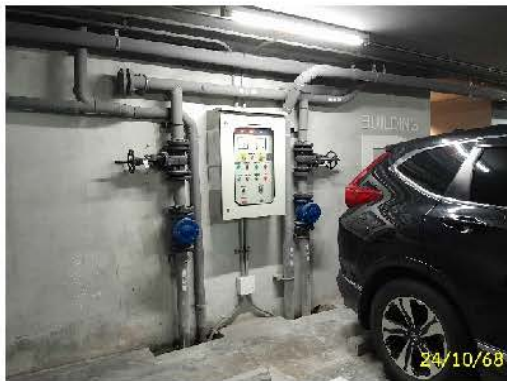
ปอร์รับน้ำฝนชั้นใต้ดิน และตู้ควบคุม ตัวที่ 1
